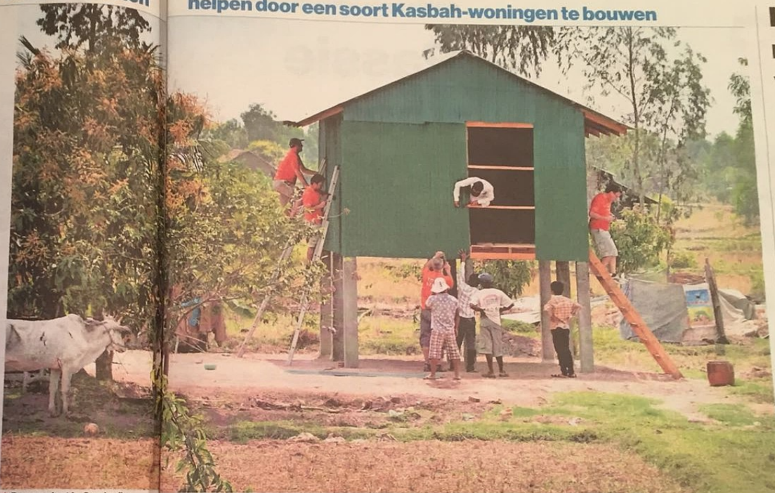
▲ Bouwproject in Cambodja.
